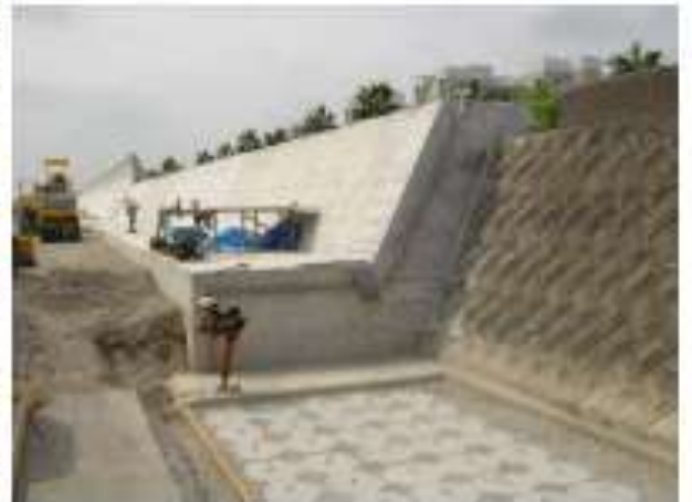
震災前の施工状況
