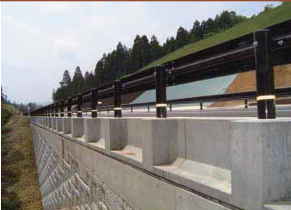
「Gベース」は、品質・工期・安全性・施工性・経済性・メンテナンスなどあらゆる面で現場打ち工法に比べて多くの長所を持った画期的なたわみ性防護柵用基礎ブロックです。「Gベース」は、車両の衝突荷重を考慮し、金沢大学の指導の下、安定・構造試験を行い、その安全性が確認され、たわみ性防護柵C種～SC種に対応しています。
