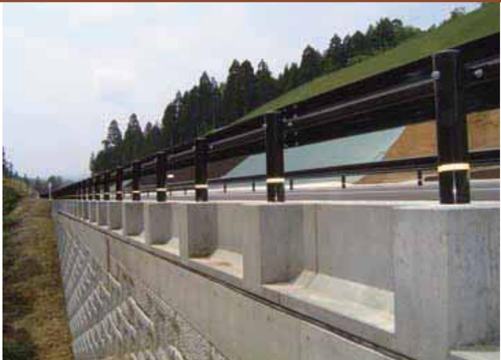
「Gベース」は、品質・工期・安全性・施工性・経済性・メンテナンスなどあらゆる面で現場打ち工法に比べて多くの長所を持った画期的なたわみ性防護柵用基礎ブロックです。
