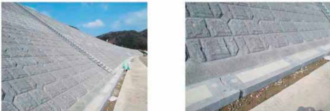
施工場所：島根県 江の川（平成 25 年度施工）
