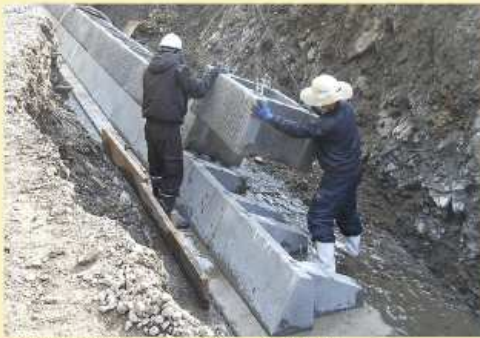
③2段目以降、本体ブロックを据付
