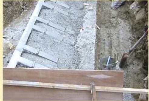
②根石ブロックの胴込コンクリート打設
