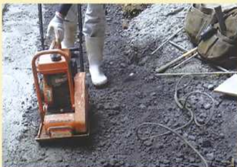
⑦抜き型枠を撤去し、裏込材を転圧
