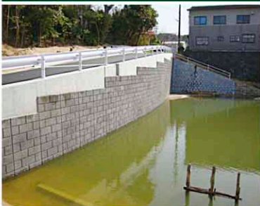
道路拡幅 護岸工
