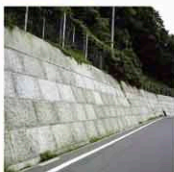
道路改良工事
