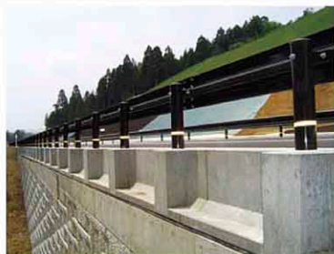
補強土壁直上
