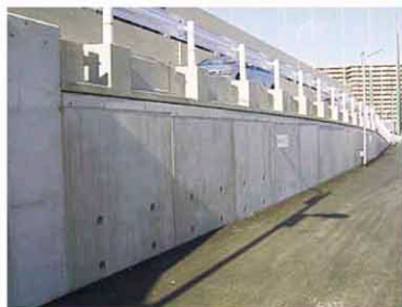
プレキャストL型擁壁直上
