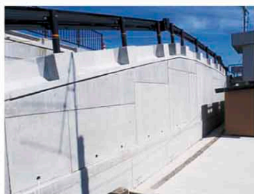
勾配変化部設置
