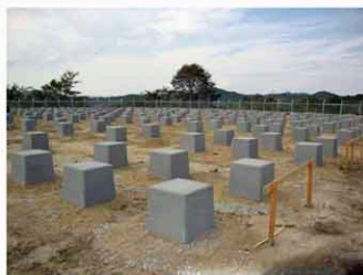
基礎ブロック設置状況
