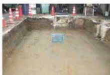
敷設面のチェック
