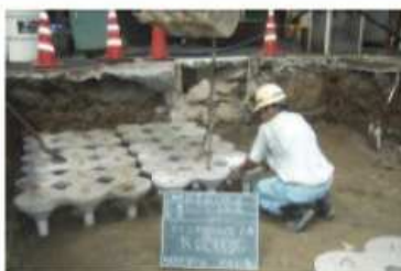
コマ型ブロック敷設
