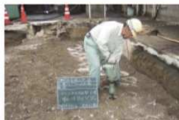
間詰碎石の充填・締め固め
