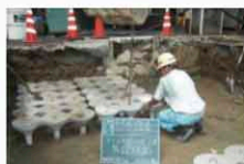
コマ型ブロック敷設
