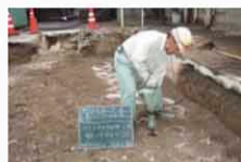
間詰砕石の充填・締め固め
