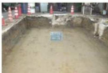
敷設面のチェック
