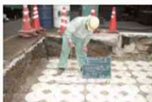
間詰砕石の充填確認
