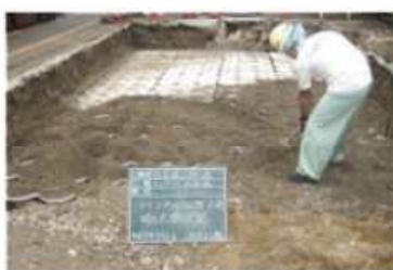
間詰碎石の充填・締め固め
