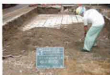
間詰砕石の充填・締め固め
