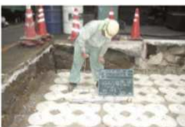
間詰碎石の充填確認
