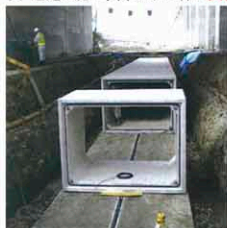
高架下でのボックスカルバート搬送・据付け工法
