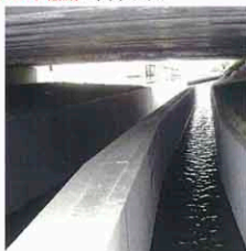
高架下での大型フレウム搬送・据付け工法
