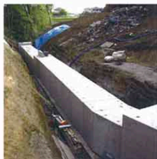
狭隘な場所の落差工でのボックスカルバート搬送・据付け工法
