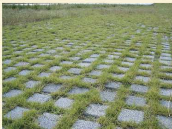
河川・高水敷
