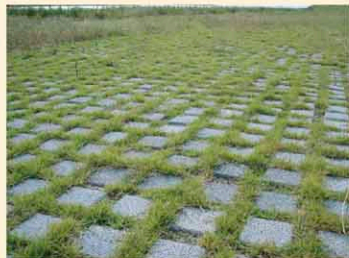
河川・高水敷
