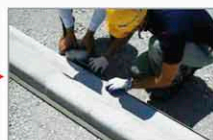
③ポーソーシールTを接着させる際は舗装面と同じ高さになるように調整してください。
