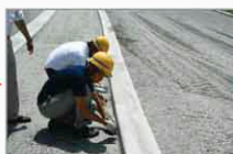
②プライマーが乾燥した後、ポーソーシールTを押し付けて接着させます。
