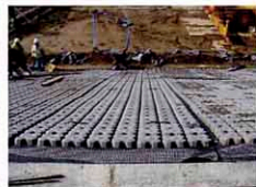
ブロックマット敷設完了
