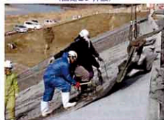
ブロックマット設置 （固定ピン打設）
