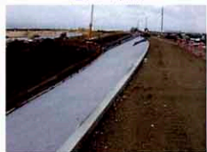
遮水シート敷設
