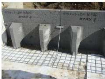
ブロック設置、金網取付
