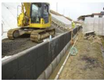
ドレーン材投入
