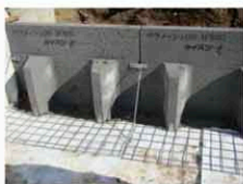
ブロック設置、金網取付
