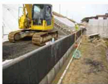
ドレーン材投入
