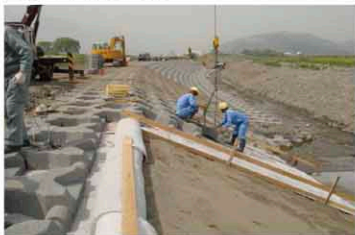
天端・法面部施工状況
