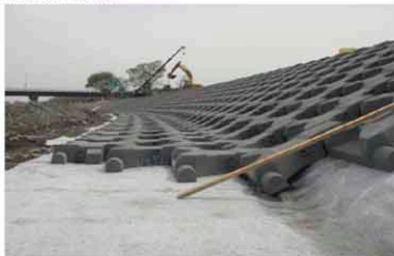
垂部施工状況
