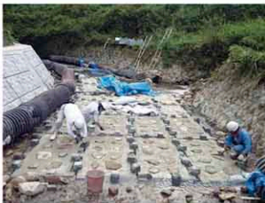
2t標準施工 植石施工
