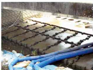
2t標準施工 橋梁下施工
