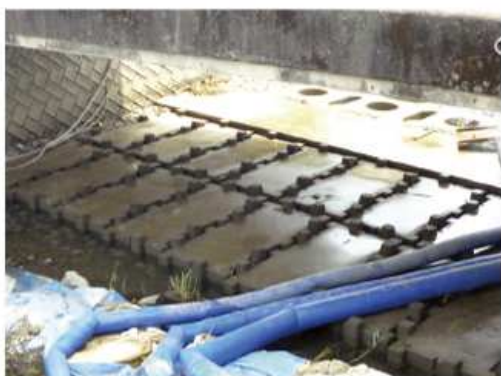
2t標準施工 橋梁下施工
