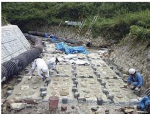
2t標準施工 植石施工
