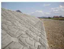
連結部着色コンクリート処理
