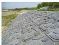
連結部碎石処理
