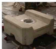
④型枠脱型
