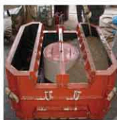
②コンクリート打設
