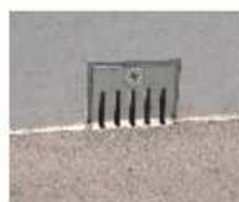
車道部排水孔 (50cm間隔)
