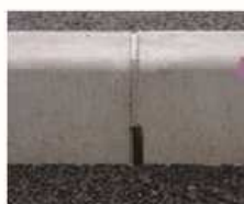
歩道部排水孔
