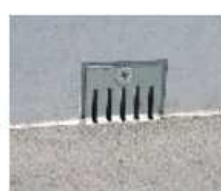
車道部排水孔 (50cm間隔)
