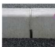
歩道部排水孔
