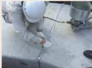
上部より頂版天端部へ注入(曲線部)
