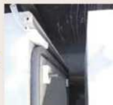
TBジョイントバー挿入状況
