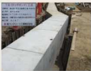
曲線部も直線部と同じ施工!
