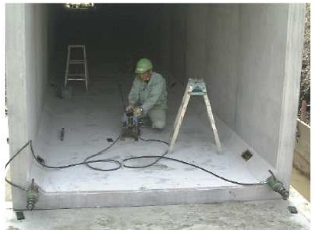
※縦締は2連同時緊張ジャッキを使用
