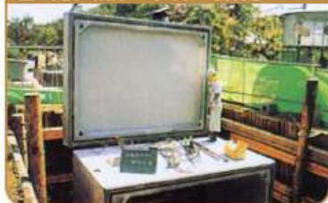
5 背面版D本体C据付
