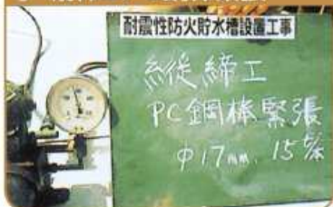
7 縦締工PC鋼棒緊張
