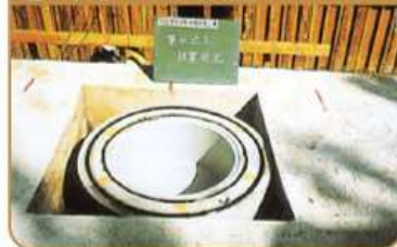
3 集水ピット設置
