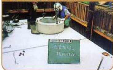
10 吸管投入孔据付
